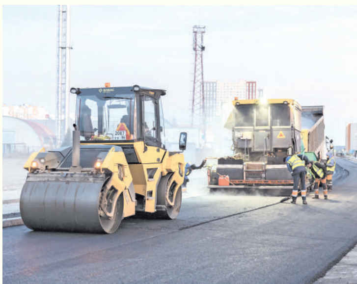
Завершен первый этап работ по обустройству улично-дорожной сети в микрорайоне «Иртыш-2».
